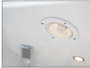
Lüfter in der Duschkabine (nur für TDL und 780 DGLE)
